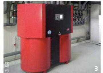
1 La centrale à détente directe est composée de 4 compresseurs piston Bitzer. 2 Damien Garrigues co-gérant gaec du quart entre Sébastien Casterman (Honeywell) et Benoît Duparc. 3 Les absorbeurs de CO<sub>2</sub> (ici un équipement sur une autre installation) sont indispensables pour une bonne conservation des fruits.
